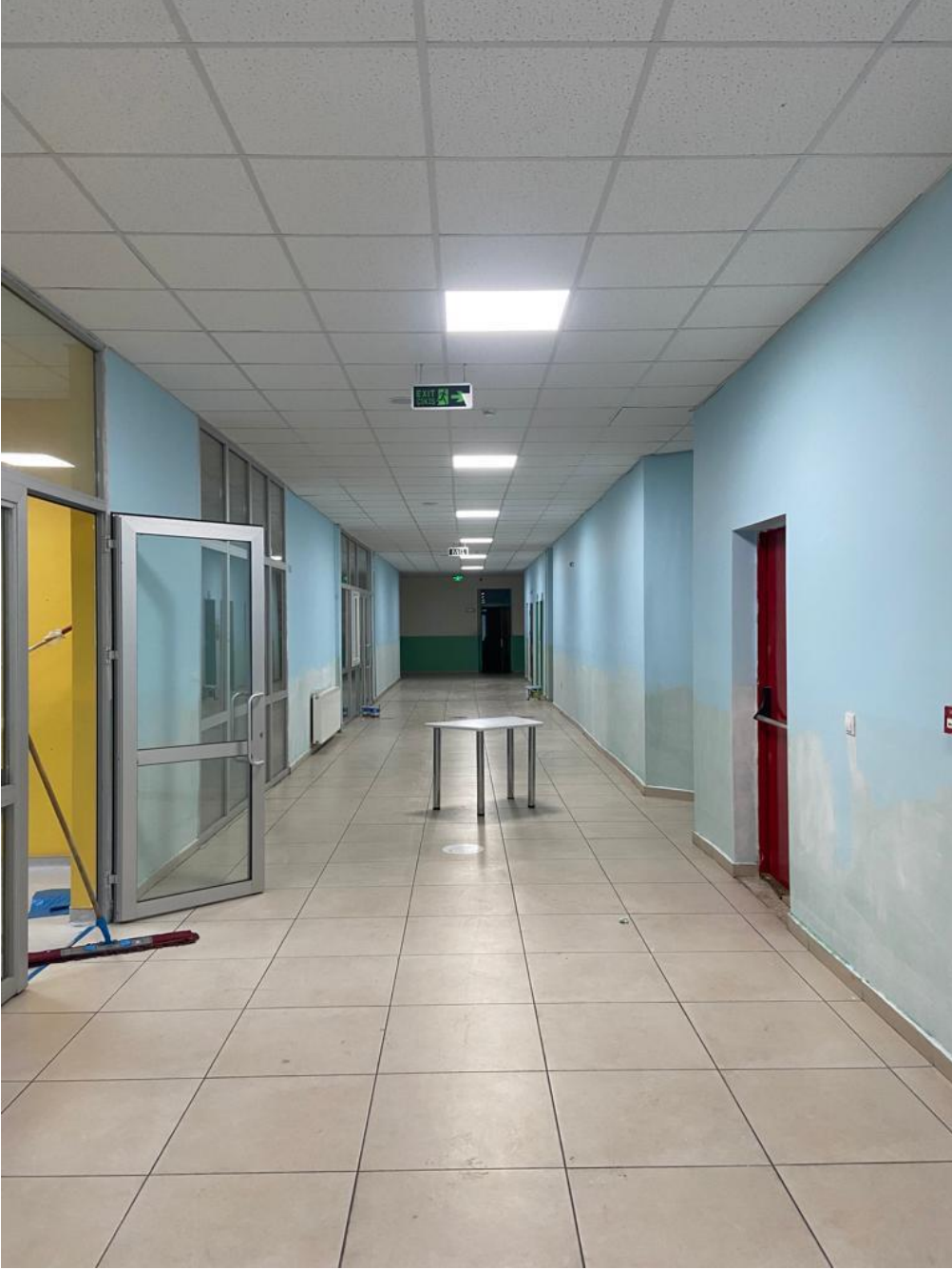
Kütüphane koridorunun görsel çalışmaların yapılmadan önceki durumu
