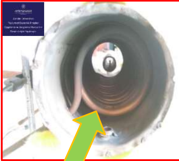
Şekil 4. Kazan içi bakır serpantin boru.
