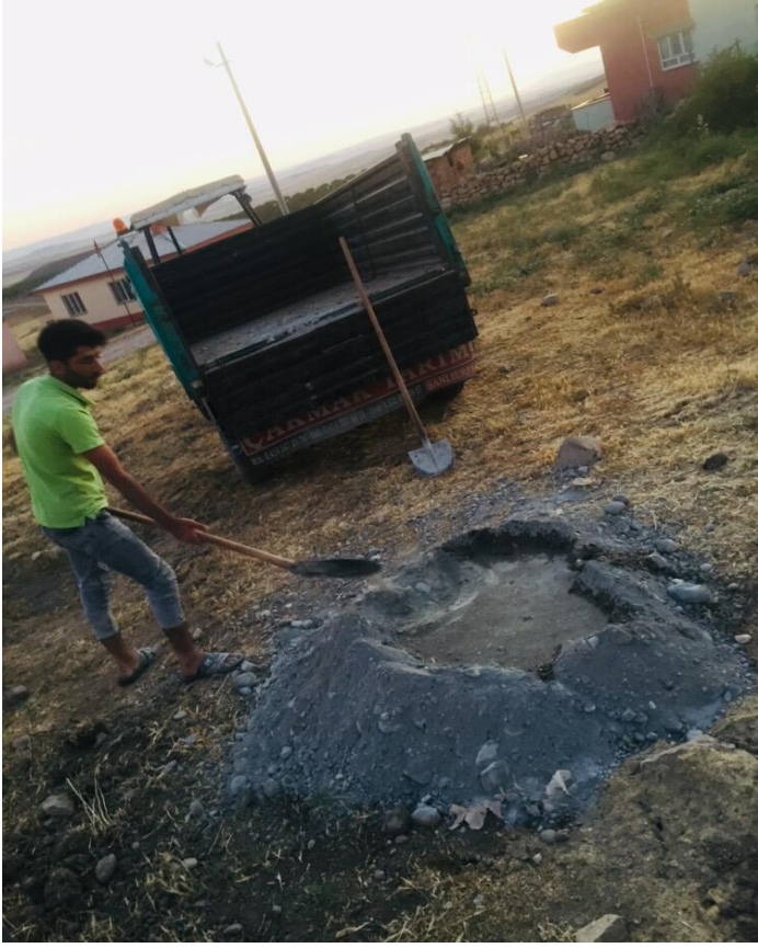
Projede kullanılacak beton harcının yapımına başlanması
