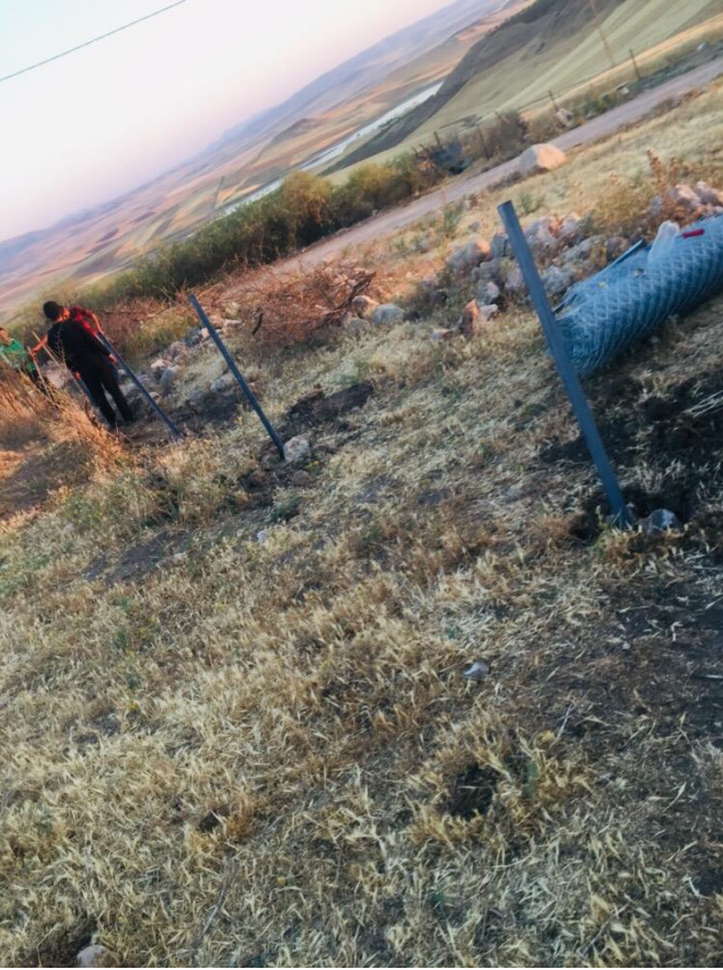
Proje kapsamında temin edilen demir direklerin kazılan çukurlara dikilerek taşlarla desteklenmesi
