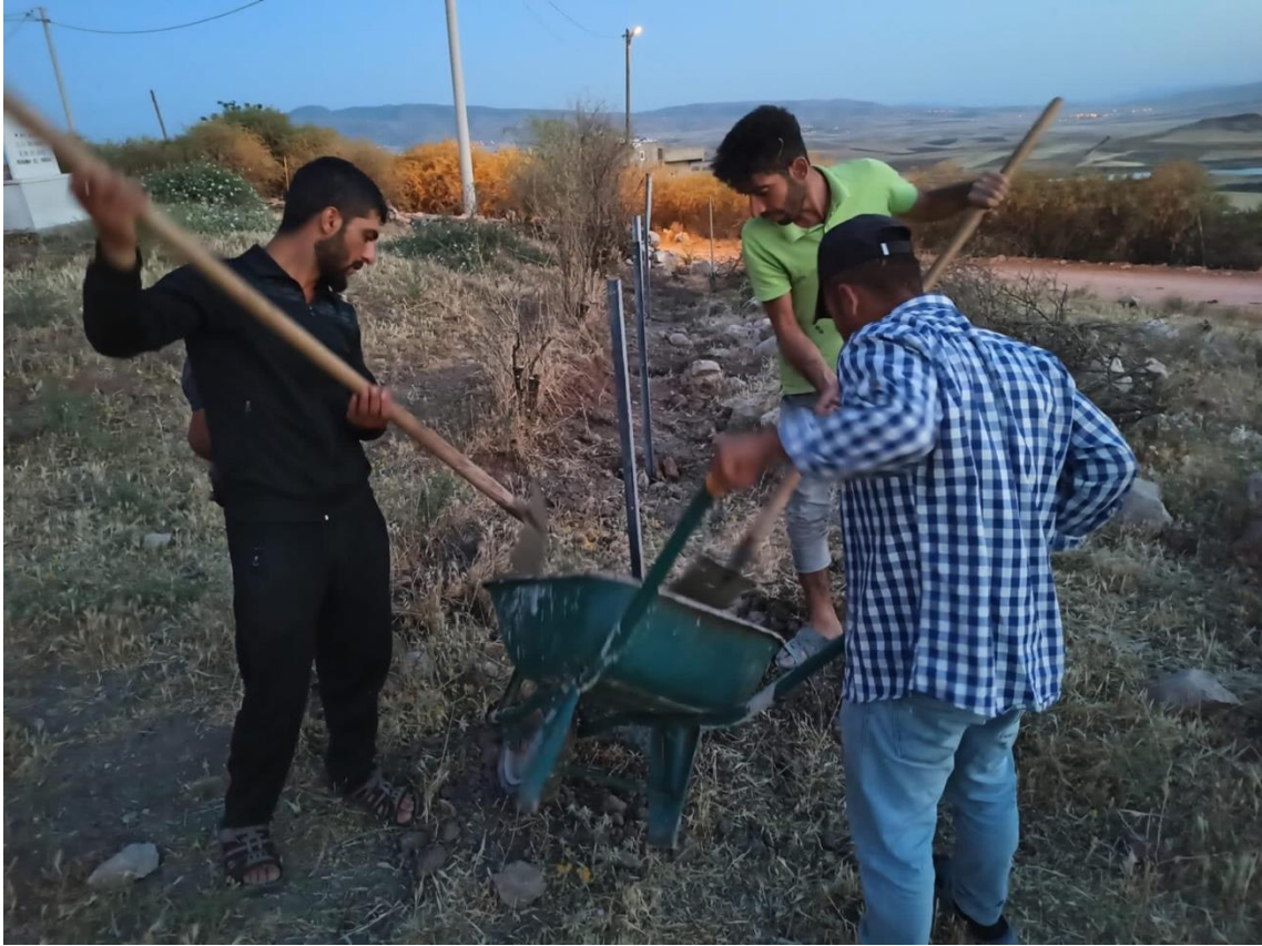
Proje Kapsamında kullanılacak beton harcının karması ve dikilen direklerin çukurlarına dökülmesi
