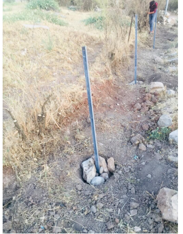
Proje kapsamında temin edilen demir direklerin kazılan çukurlara dikilerek taşlarla desteklenmesi
